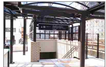
③新地下階段整備
