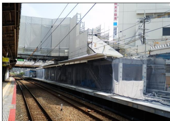
乗換通路工事（下り線）
