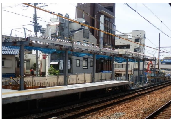
新西口改札工事（下り線）
