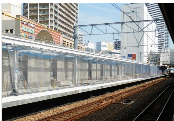
ホーム新設工事（上り線）
