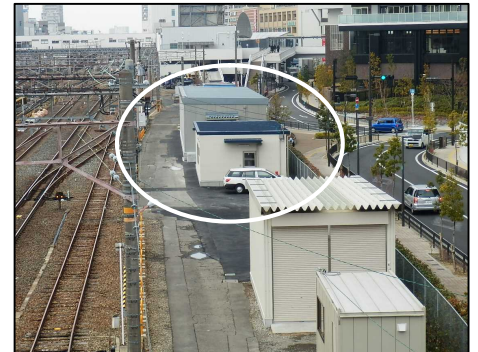
電気設備の支障移転状況
