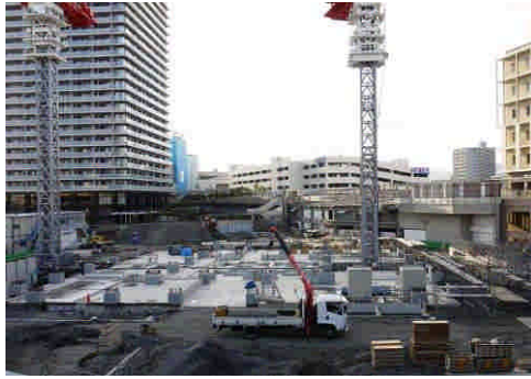
(集合住宅B：東側より)
