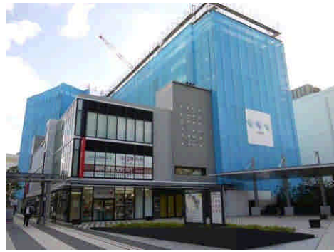
(複合棟A：北側より)
