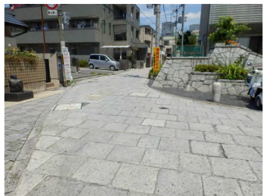
国道171号より北部2 石畳風の舗装や石積
