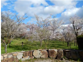
地盤を高くして境に石積を設置する
