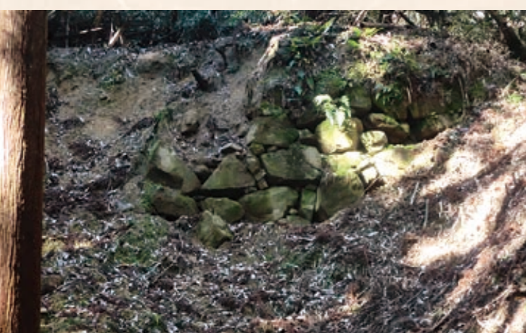
大手石垣 城への正門である「大手」に築かれた高さ2m以上の石垣。この石垣には登城者に城主の力を見せる役割がある
