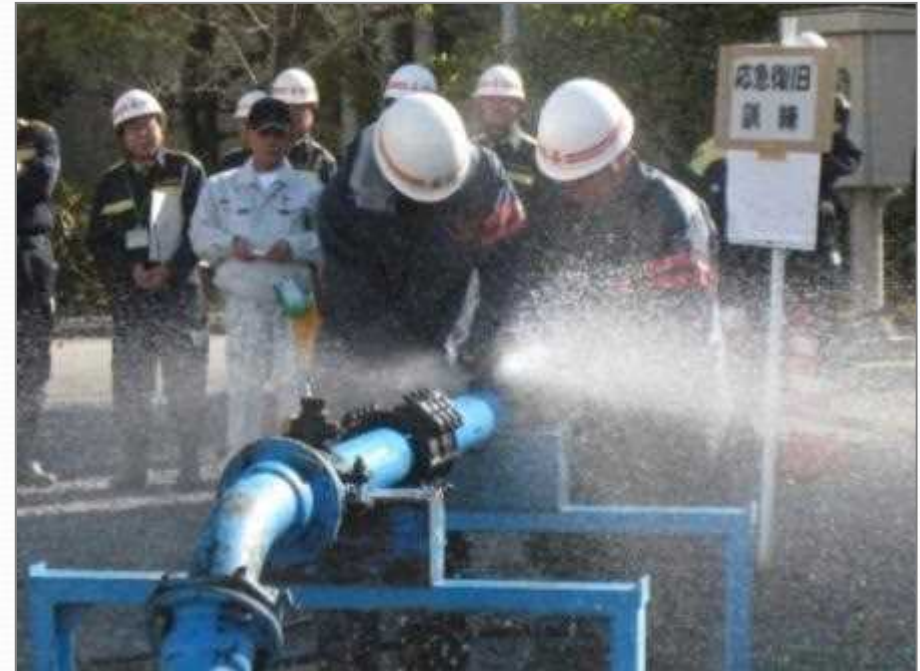
【応急復旧訓練】
