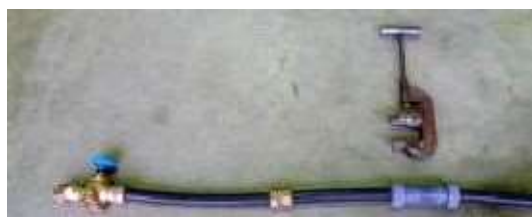
③ PPソケットで既設管と新設を接続し、伸縮ソケットを圧着箇所を設置する。
