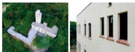
設計者は、大学施設などに作品の多い大倉三郎。東西2棟とそれらをつなぐ玄関棟は、床のレベルを細かく変え、地形に沿わせて設計されている。本館棟は、よく見ると、少しずつずらした凝りに凝った構造。各階の窓は縦にひとつながりに見えるよう、最上階だけが角丸のデザインになっている
