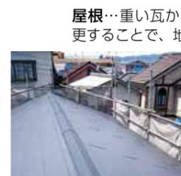
屋根…重い瓦から軽いスレートに変更することで、地震時の揺れを抑える
