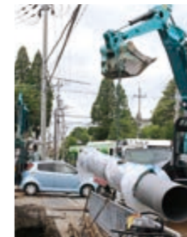
水道管工事の様子
