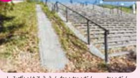
清水池公園内階段。階段の横にあるコンクリートが、急で滑り止めもなく、階段途中で途切れている。
