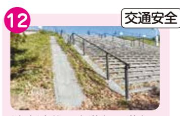
清水池公園内階段。階段の横にあるコンクリートが、急で滑り止めもなく、階段途中で途切れている。
