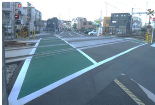
➤カラー舗装を導入した事例
