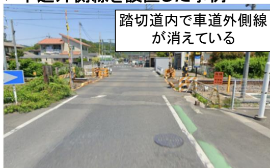
➤車道外側線を設置した事例
