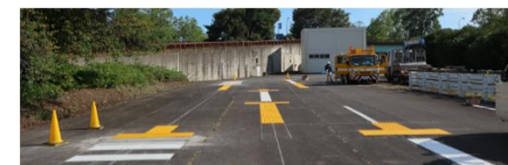
予備実験（踏切手前部）の誘導表示等の敷設状況
