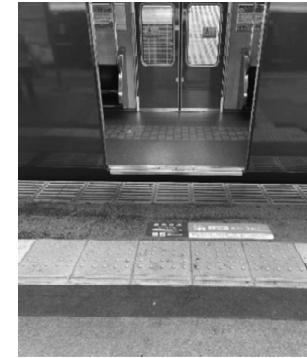
ホームとの段差
