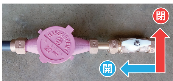
【コック式】写真の状態が 開 90度回転で 閉
