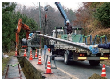
水道管の更新工事
