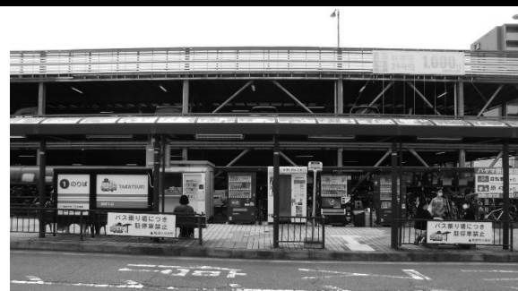
JR摂津富田駅（視覚障がい者誘導用ブロック）
