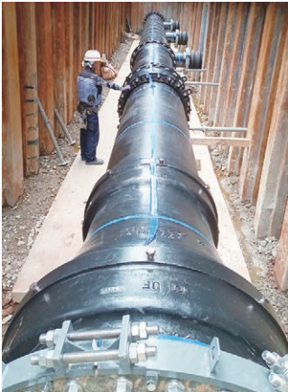
水道管更新工事の様子
