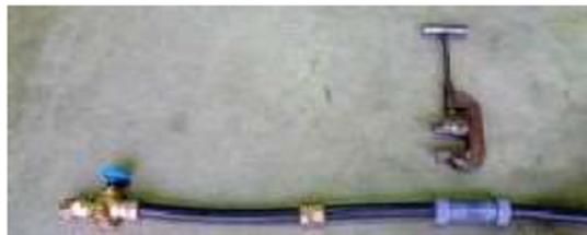
③ PPソケットで既設管と新設を接続し、伸縮ソケットを圧着箇所に設置する。
