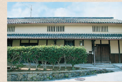
富田で最古の町家。玄関、勝手口、荷物の搬入口の3つの入り口がある
