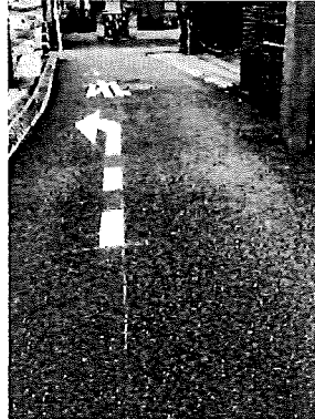
芥川町2丁目●西国街道 での逆走防止対策
