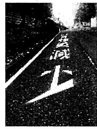
真上町6丁目 ●狭隘道路接触事故防止対策(路面標示)
